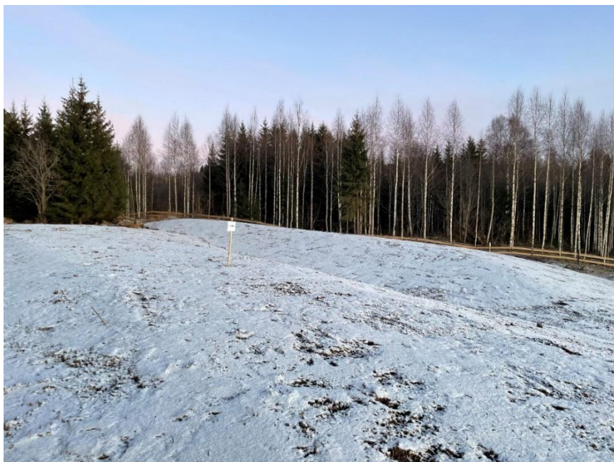
Mellomlagring av matjord der A og B sjikt lagres hver for seg. Foto: Karoline Finstad Vold
