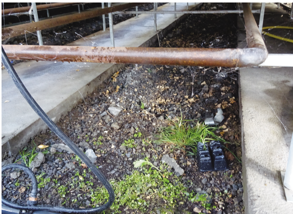
Bed mellom betongganger som er fylt igjen med grus. Kan gjøres om til dyrkingsbed ved fjerning av grus og påfylling av matjord, kompost eller anna dyrkingsmedium. Foto: Kaia Slågedal
