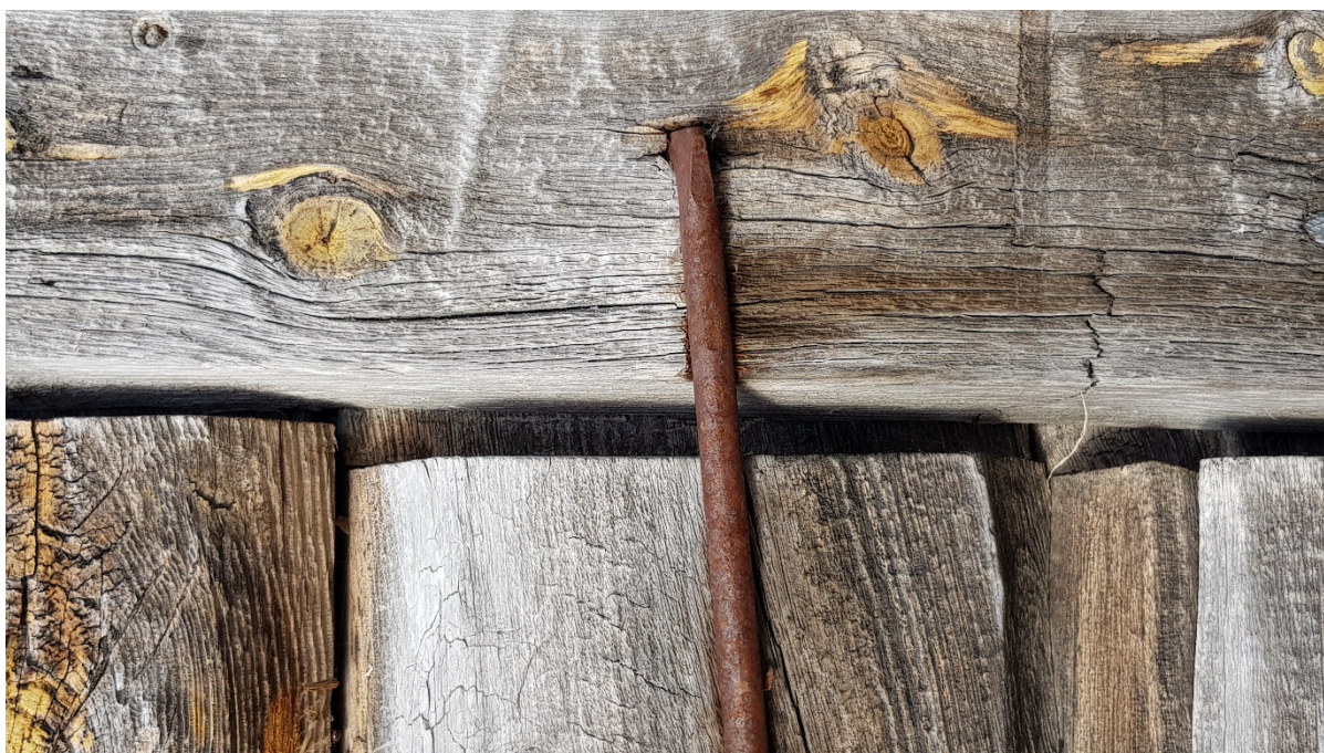
Figur 2.1 «Binding» som holder stokker på plass på et eldre tømmerhus i Salten.
