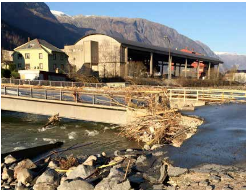
Skader i Odda etter flommen 2014.
