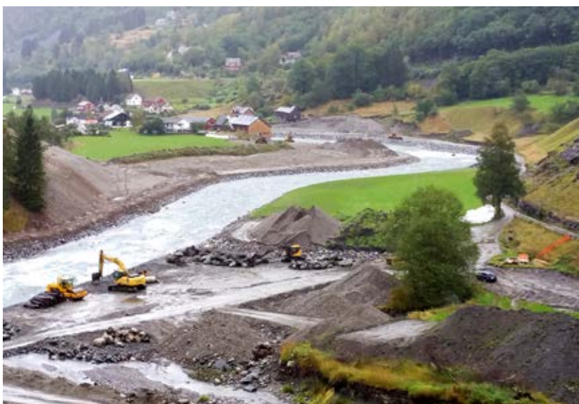
Gjenoppretingsarbeid i Flåm i Aurland kommune.
