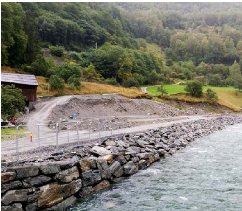
Gjenoppretings- og sikringsarbeid i Flåm i Aurland kommune.
